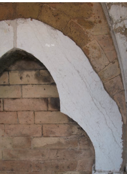
Fig. 14 Archetto in pietra d'Istria. Sono visibili le caratteristiche discontinuità sature chiamate stiloliti. Lanterna, lato est.
