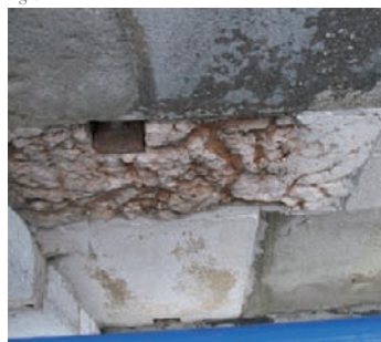
Fig. 11 Esfoliazione con distacco degli strati superficiali da un concio in trachite. Lato est, terzo piano. Exfoliation with flake detachment from a trachyte slab. Third floor, eastern side.
