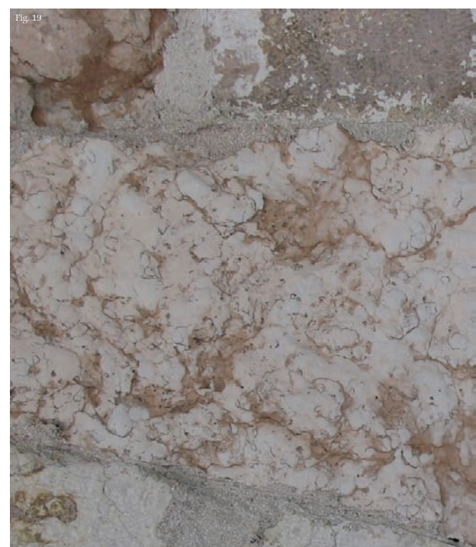
Fig. 19 Lastra di sostituzione in Scaglia rossa (pietra di Prun) installata nel paramento durante i restauri del 1973, come rivelato dalla presenza di tracce di utilizzo di una troncatrice meccanica. Sesto piano, lato est. Slab of Scaglia rossa ( pietra di Prun ) emplaced during the 1973 restorations, as revealed by modern tool marks. Sixth floor, eastern side.
