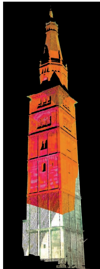
Vista prospettica dell'immagine termografica georeferenziata con la restituzione del rilievo laser scanner (camera Flyr mod.B400 sensibilità termica pari a 50 mK). Perspective view of the thermographic, georeferenced image with rendering of the laser scanner survey (Flyr mod. B400 camera; thermal sensitivity of 50 mK).
