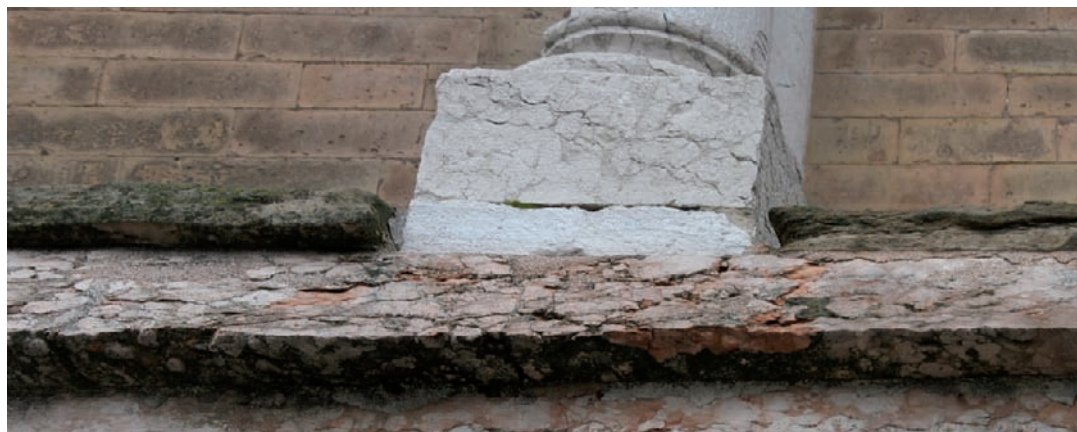
Fig. 22 Davanzali in Arenaria di Scabiazza profondamente alterati da fenomeni di disaggregazione.
