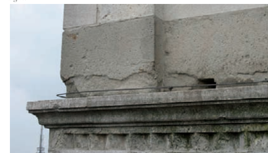
Fig. 12 Scavernamento di blocchi di trachite in prossimità dei cornicioni. L'alterazione concentrata è legata all'effetto combinato del ristagno di umidità e dell'azione degli schizzi di pioggia battente sui cornicioni. Quinto piano, lato ovest. Back weathering of trachyte just above the cornice. This localized degradation is related to water stagnation and the mechanical erosion of splashing raindrops. Fifth floor, western side.
