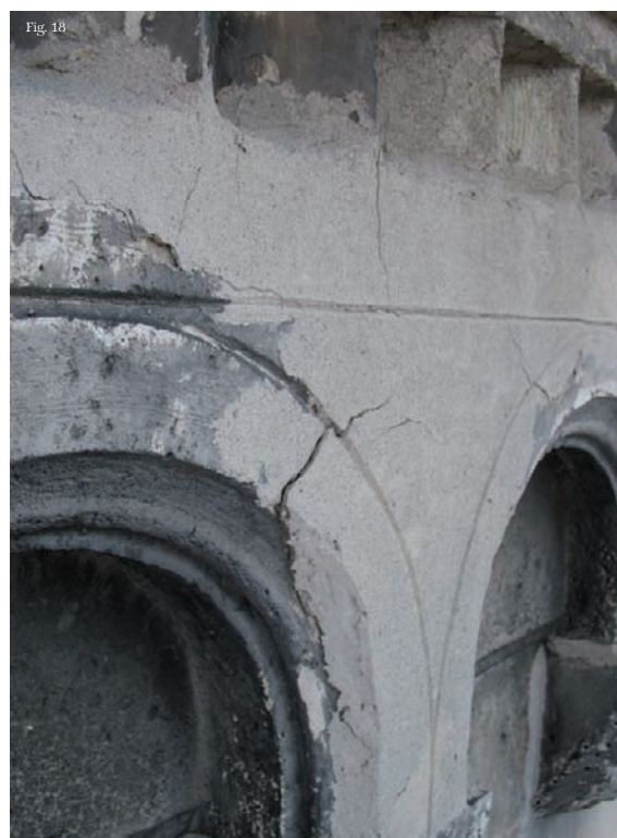
Fig. 18 Stuccatura in resina epossidica di un'ampia porzione della quarta cornice del lato ovest effettuata durante i restauri degli anni Settanta. Notare la fratturazione della resina. Integration by epoxy resin of a large portion of the fourth cornice on the western façade during the '70s restorations. Note the cracking of the resin.
