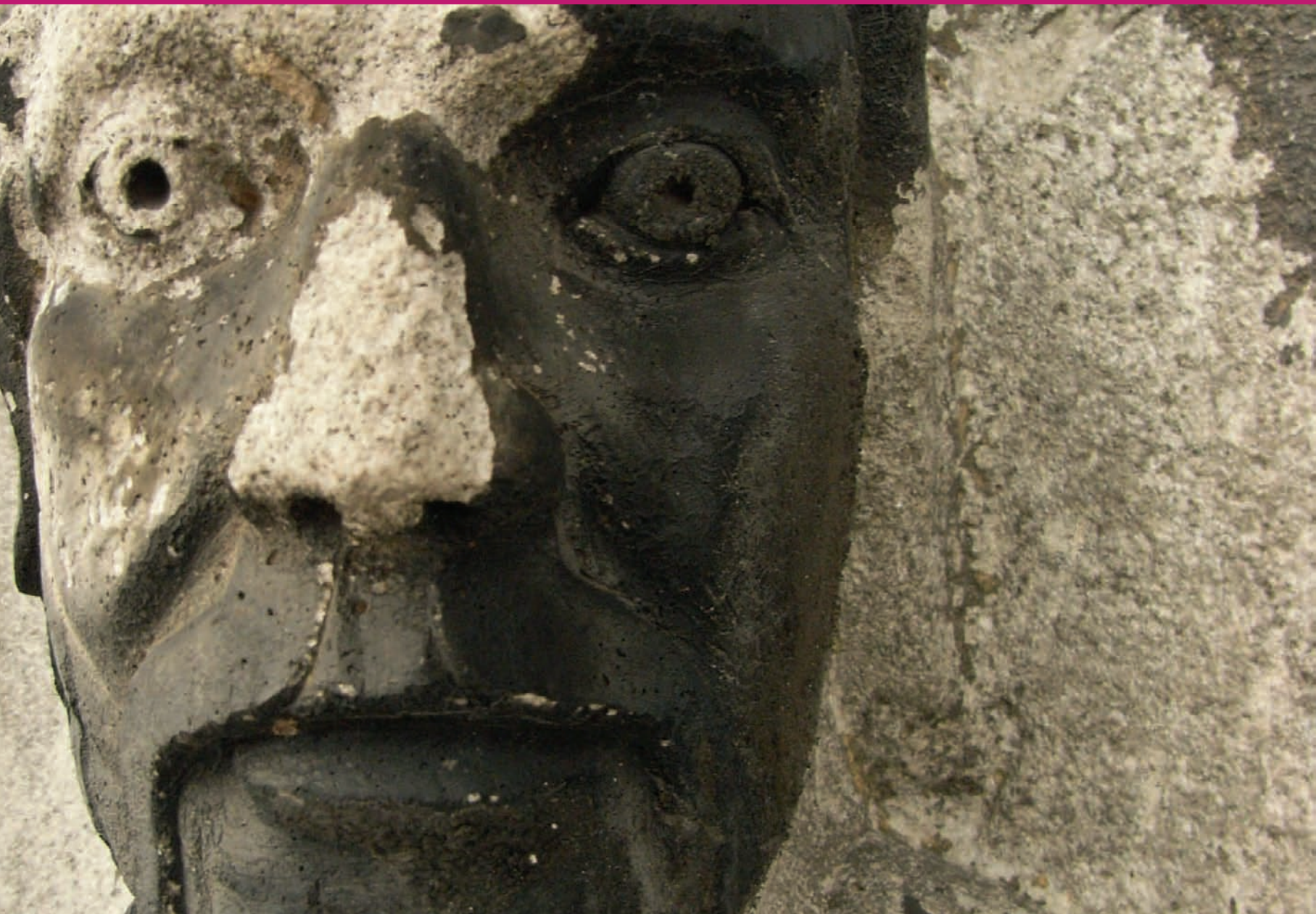
Fig. 5 Particolare di un bassorilievo in cui è presente una pesante crosta nera.
