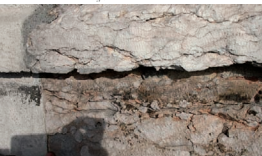
Fig. 8 Degradazione differenziale su di una lastra in Rosso Ammonitico. Lato est, terzo piano. Differential degradation of Rosso Ammonitico. Third floor, eastern side.
