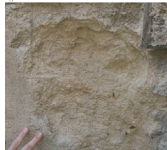
Fig. 12 Scavernamento di blocchi di trachite in prossimità dei cornicioni. L'alterazione concentrata è legata all'effetto combinato del ristagno di umidità e dell'azione degli schizzi di pioggia battente sui cornicioni. Quinto piano, lato ovest. Back weathering of trachyte just above the cornice. This localized degradation is related to water stagnation and the mechanical erosion of splashing raindrops. Fifth floor, western side.
