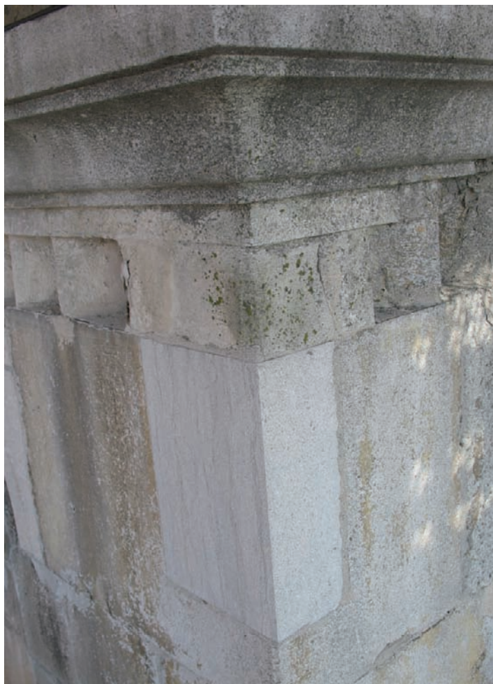
Fig. 26 Blocco di pietra di Chiampo (grigio chiaro). A sinistra sono visibili le caratteristiche stiloliti. Pietra di Chiampo angular element (light grey) showing its characteristic stylolites (on the left).
