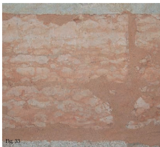
Fig. 32 Concio di Rosso di Verona oggetto delle prove di stuccatura prima dell'intervento. Blocks of Red Verona stone prior to filler testing interventions.
